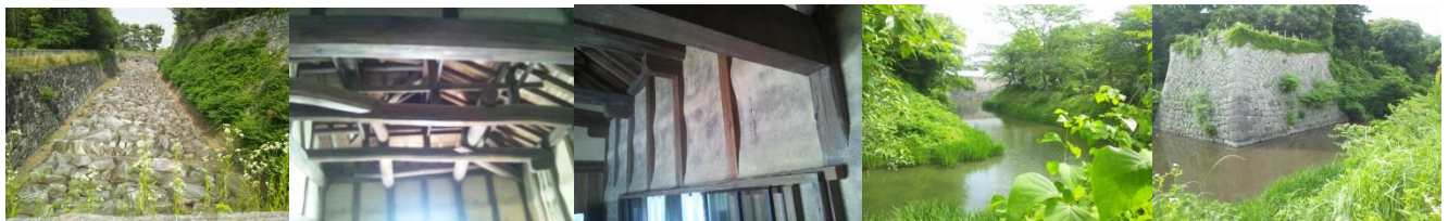
名古屋城本丸空堀石置場 彦根城佐和口多聞櫓内部2景 水口城本丸堀 水口櫓台
